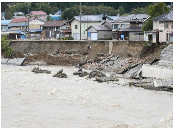
写真 1 上福井地内 国道・住宅被災
