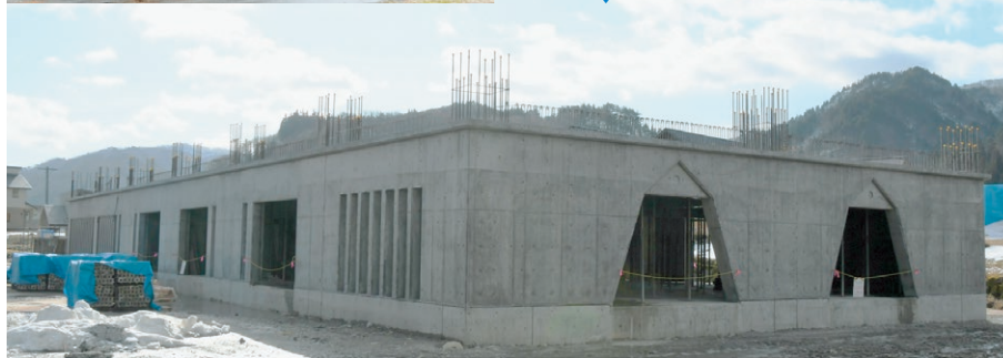
▲建設中※1月末時点
