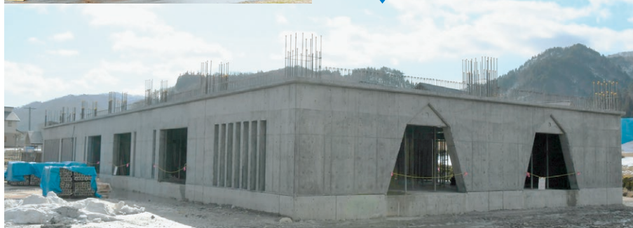
▲建設中※1月末時点
