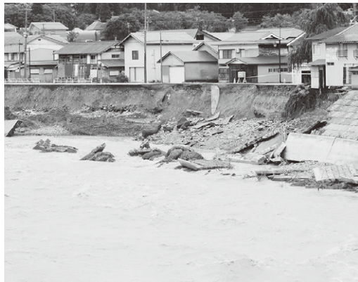
▲伊南川の増水により崩落した国道289号（福井三日町地内）
