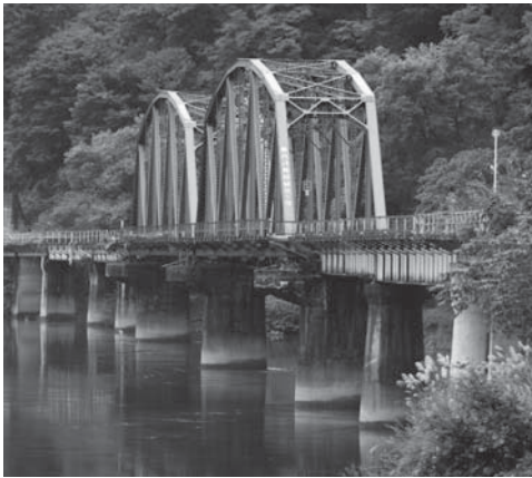
▲これから工事が始まる第8只見川橋りょう (寄岩)
