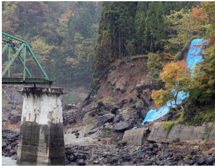
▲第5只見川橋梁(金山町)【橋げた流失】 (写真提供/会津ヨシ)
