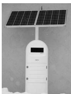
▲只見中に設置された測定機器
