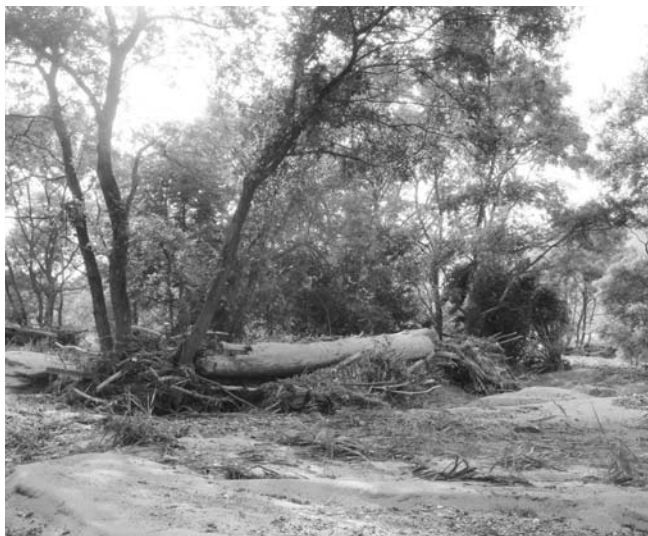
写真4：比高の高い氾濫原に成立するユビソヤナギ林は、多量の土砂、流木を補足した
