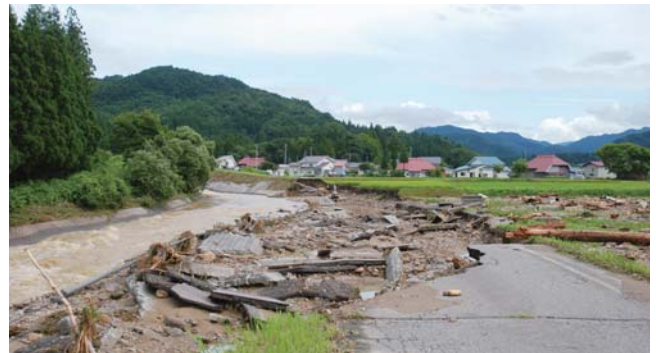
▲町道「関野土橋線」(小川地区)
