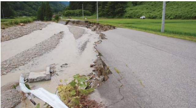
▲町道「小林塩ノ岐線」(塩ノ岐地区)
