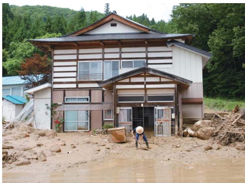
▲土石流に襲われた家屋(二軒在家地区)
