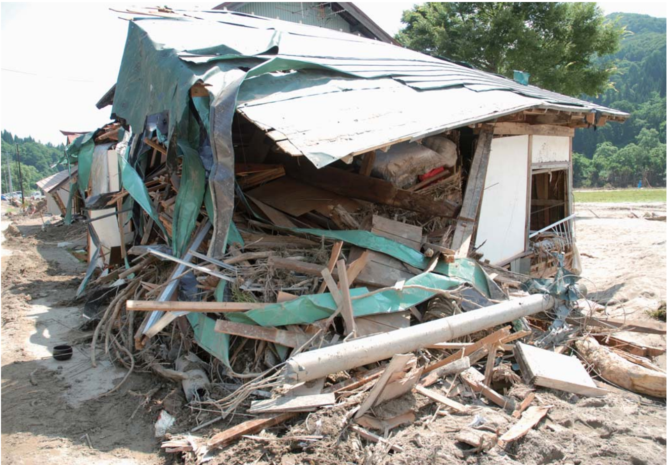
▲約50m流され、原形をとどめない家屋(八木沢地区)
