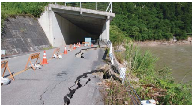
▲国道252号塩沢スノーシェッド付近
