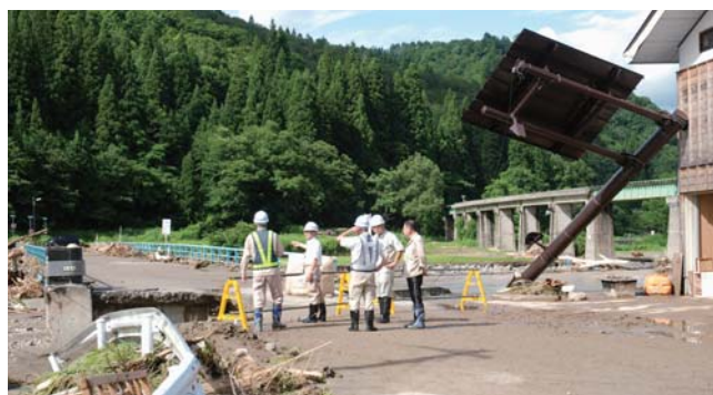
▲堅盤橋(叶津地区)
