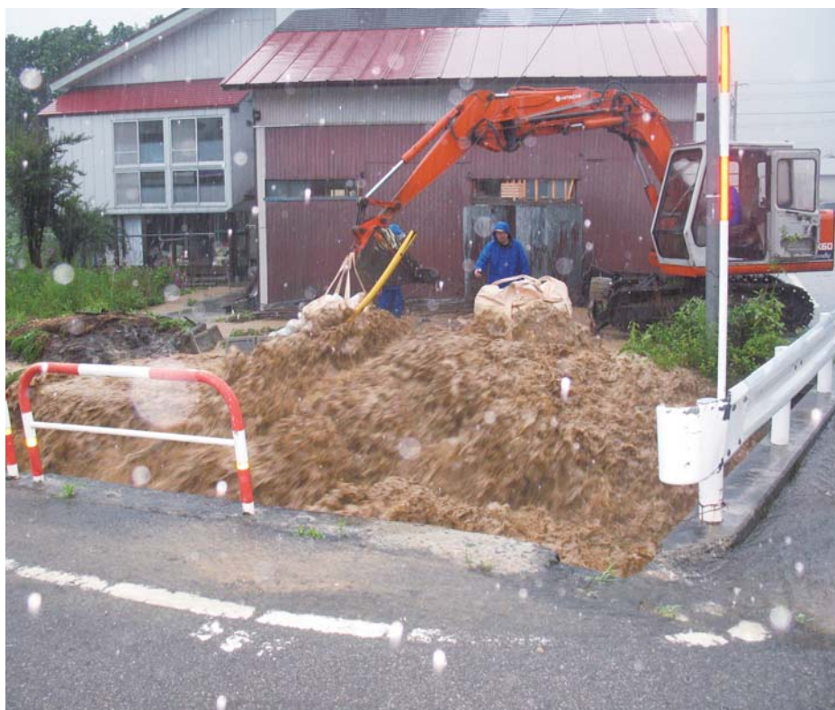
▲濁流をくい止めようと土のうを設置する町民(福井地区)
