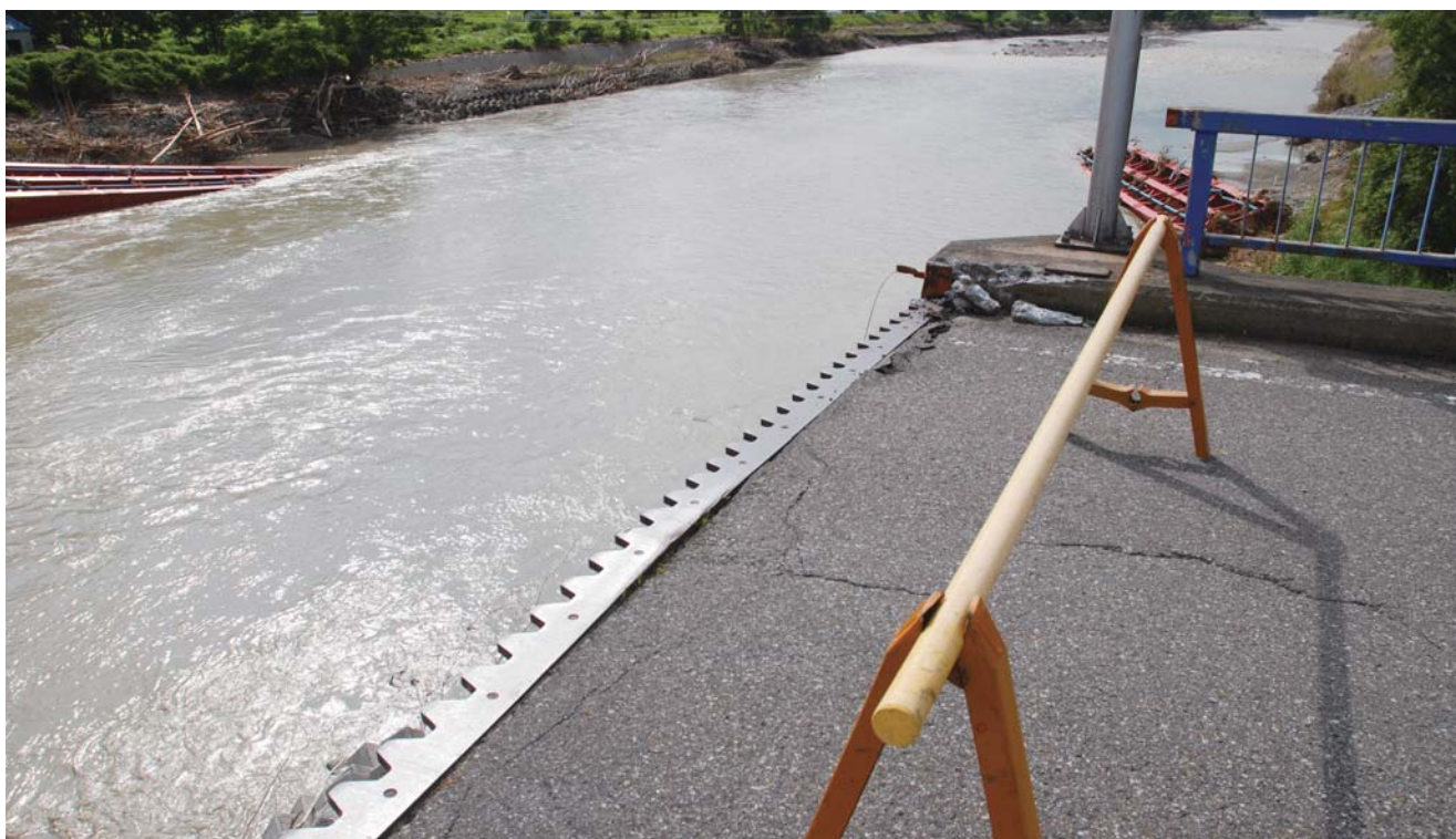
▲小川橋(小川地区)
