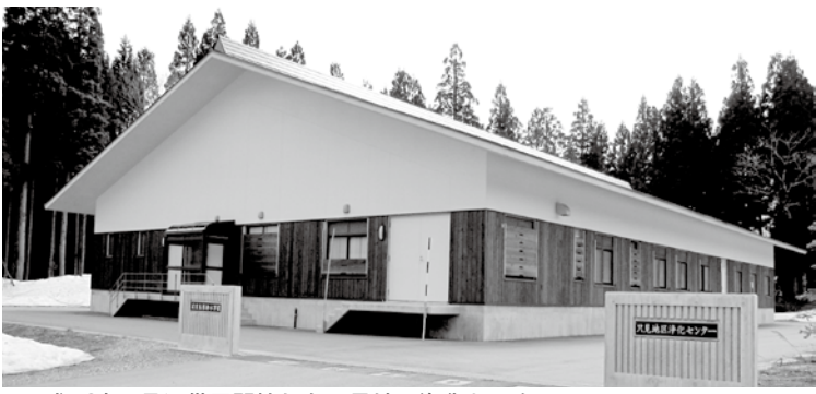
▲平成19年7月に供用開始した只見地区浄化センター
