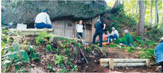
▲駅至近にあり地域の宝でもある縁結び三石神社の遊歩道整備を、只見区と共同で実施しています。
