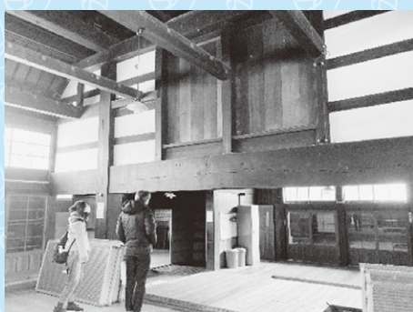
▲古民家調査の様子
