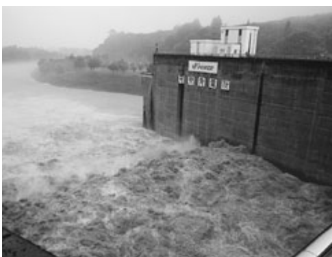
豪雨災害時における只見ダムからの放水状況
