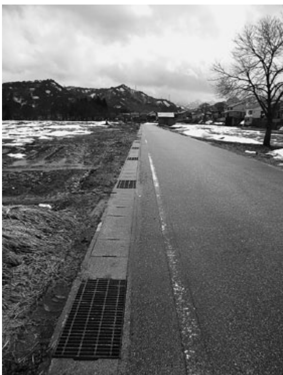
対策が求められる、豪雨災害時に甚大な被害を受けた新町・新屋敷地区
