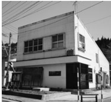
取り壊し処分が決まった旧東北電力小林サービスセンター
