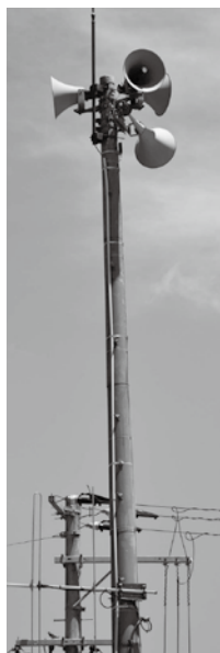
防災行政無線鉄塔
