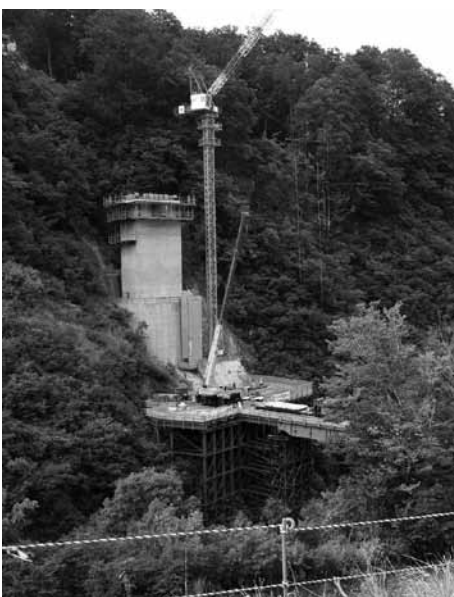
国道289号八十里越工事状況(平成30年夏)
