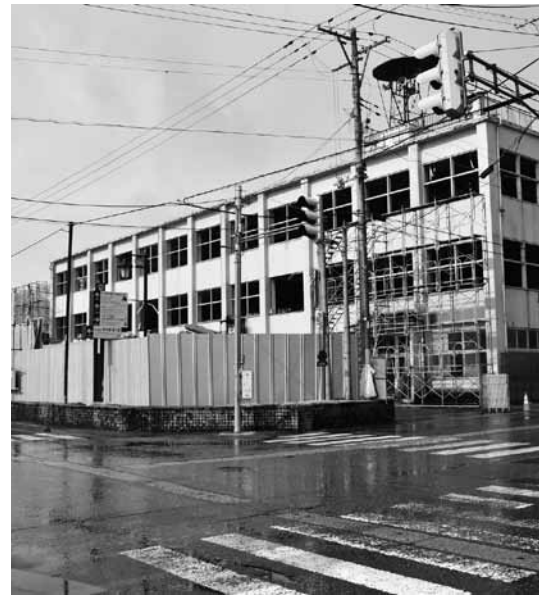
解体される旧役場庁舎
