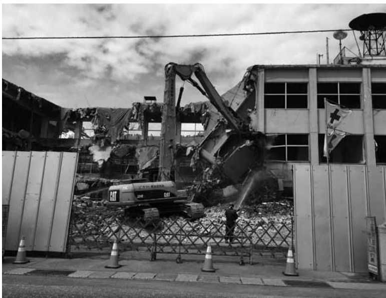
解体中の旧役場庁舎
