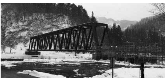
完成後は町管理となる万代橋
