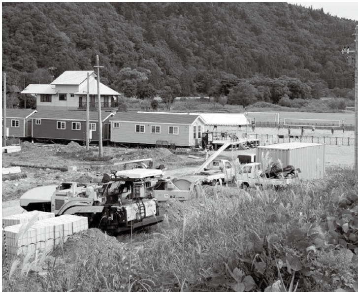
駐車場整備中の亀岡農村公園
