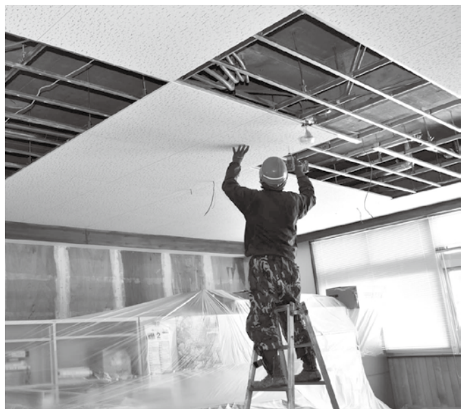
改修工事が進む町下庁舎（旧只見中学校）
