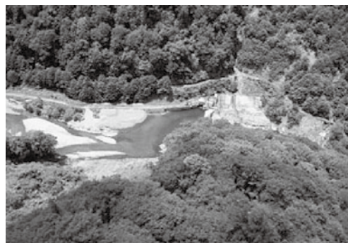
航空写真による黒谷ゴムダムの様子
