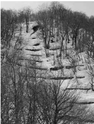
土砂崩れ発生箇所 (頂上付近)
