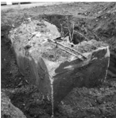
掘り出された只見総合開発センターの埋設物
