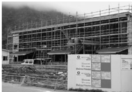
建設中の民間アパート
