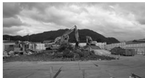
只見総合開発センターの解体作業
