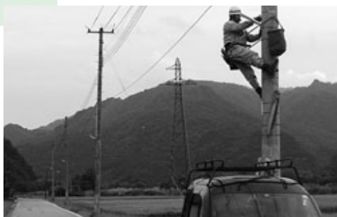
LED設置工事(小林集落)の状況
