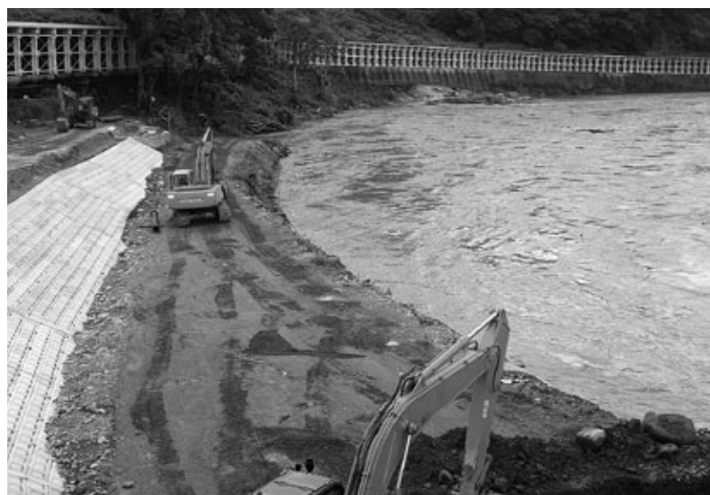
八木沢地区の河川災害復旧状況（7月下旬撮影）
