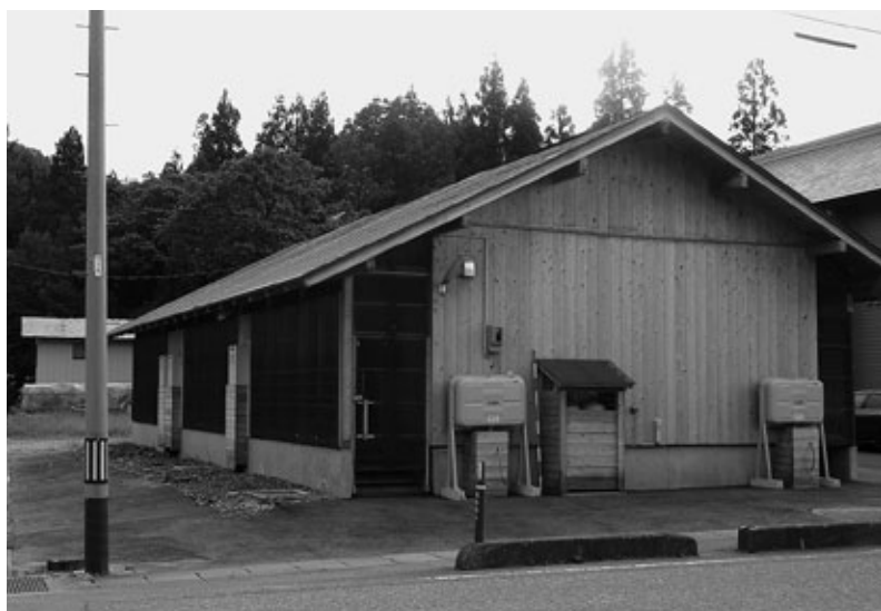
只見地区仮設住宅
