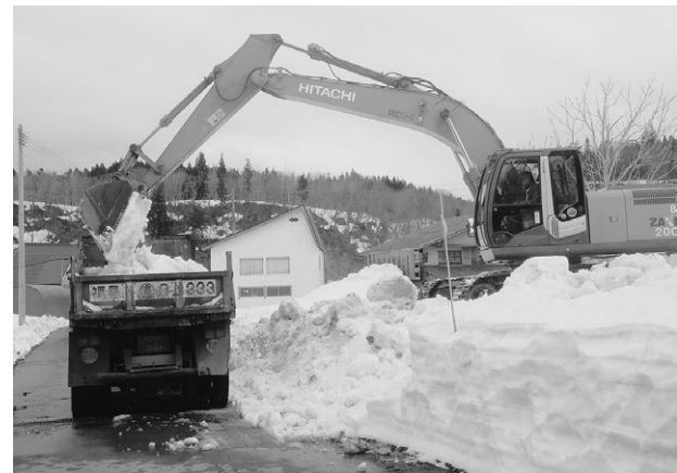
除雪体制を支える建設業
