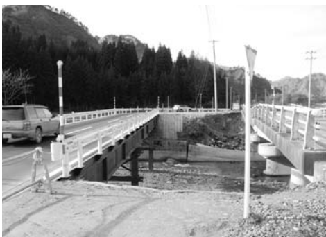
▲設置された仮設橋(左の橋)
