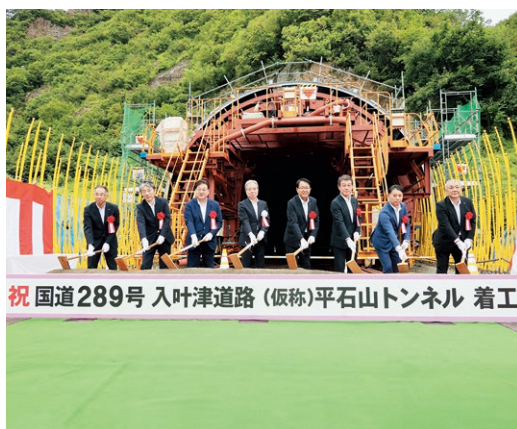
▲工事現場でくわ入れをする出席者
