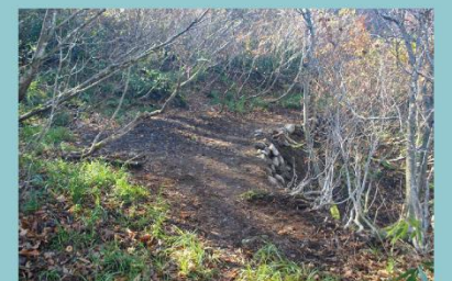
八十里越新道 路肩石積（只見町）
