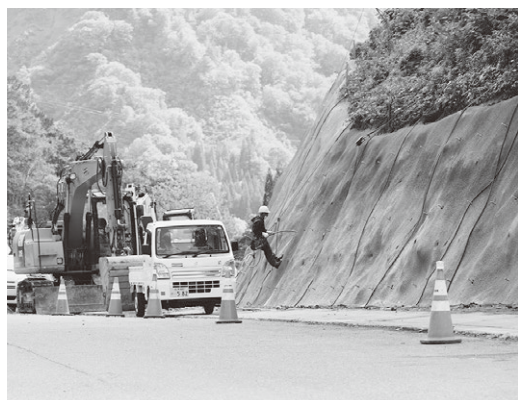
▲開通に向けて工事が進む八十里越道路
