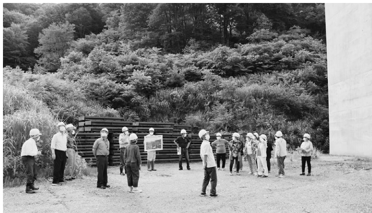
▲工事中の橋を見上げる参加者
