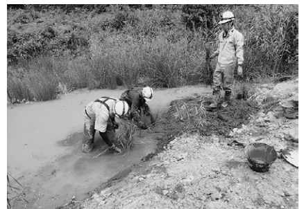
民間企業による野生動物の保全に配慮した工事施工
