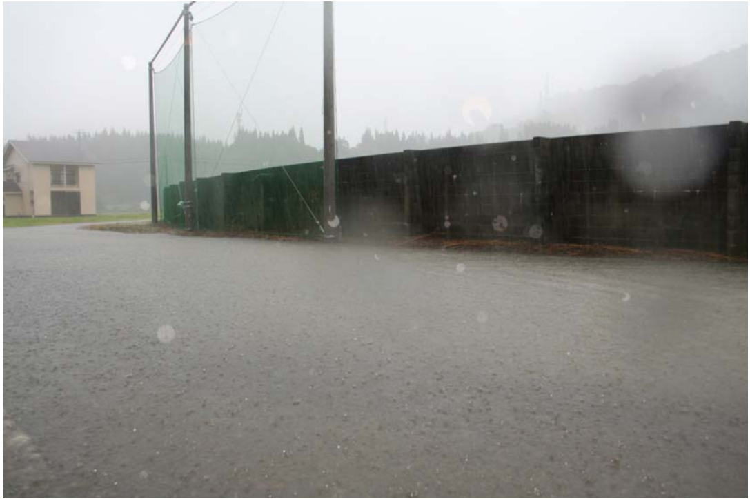
写真 4-4 旧只見中学校水害の状況 1
