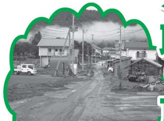
公営住宅の復旧
