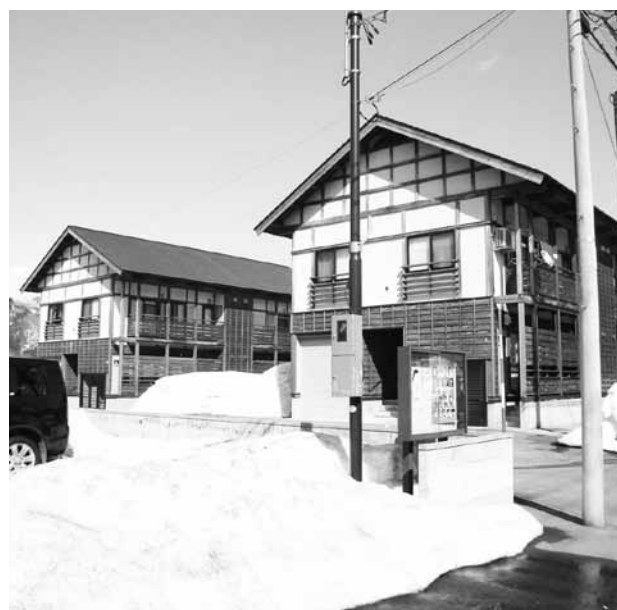
黒谷地区にある公営住宅の現状
