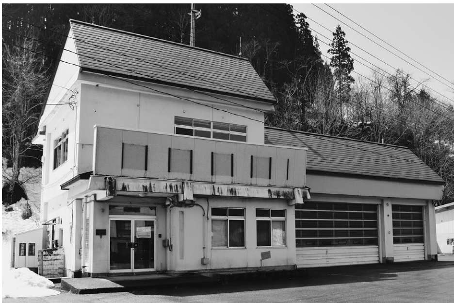
解体予定の旧庁舎
