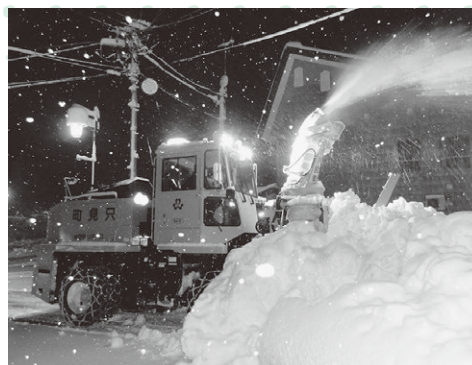
昼夜問わず、実施された除雪作業
