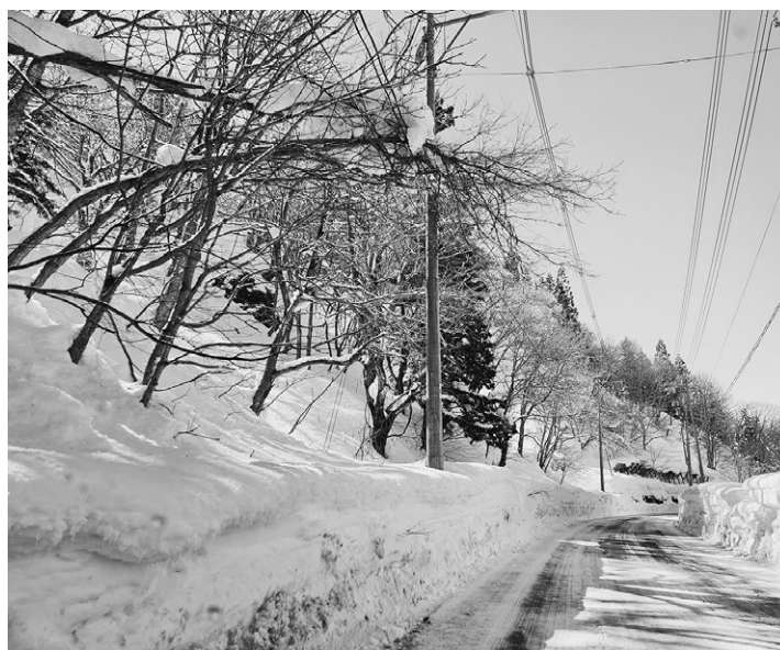
危ない……！！ 倒木の危険箇所 町内には多い
