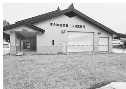
施設完成間近
