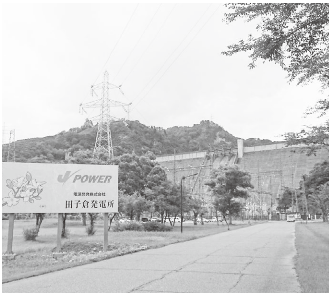
水力発電を担う田子倉発電所
