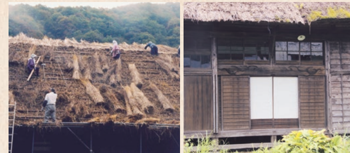
屋根の葺替え(平成13年)
