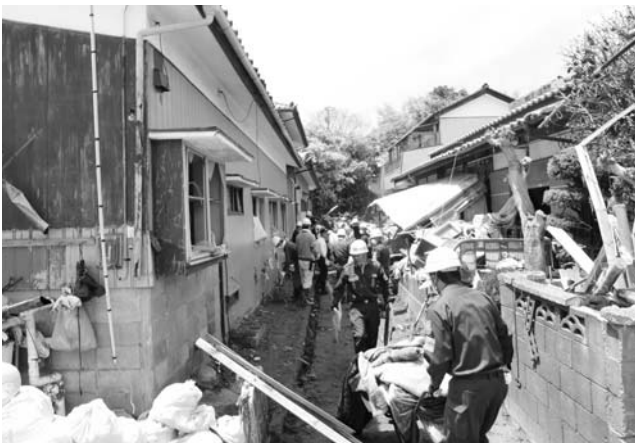
▲ がれきなどの撤去作業に当たる消防団員ら
