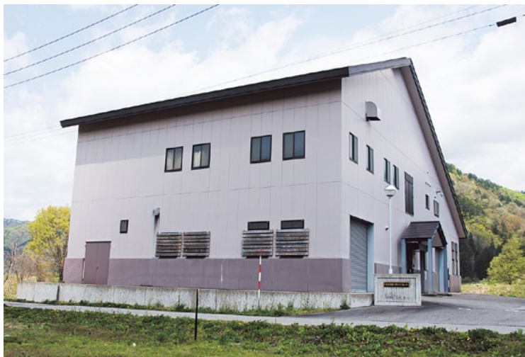
コンポスト肥料「ただみコンポ」を生産、販売する資源リサイクルセンター（下福井）
